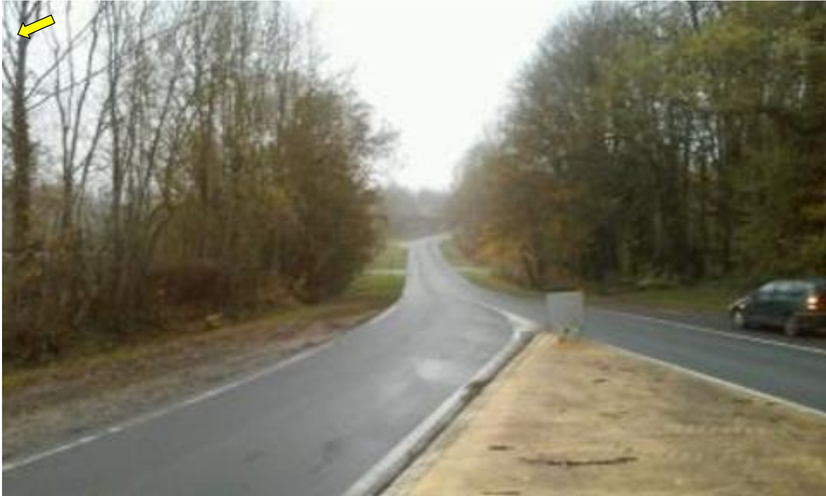
Photo de la RD 158 (le site d'étude est situé à gauche derrière l'alignement d'arbres)
